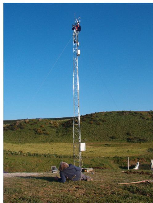
Figure 18: Mesure intégrée de l'évapotranspiration réelle. Anémomètre sonique et hygromètre installés à 10m du sol
